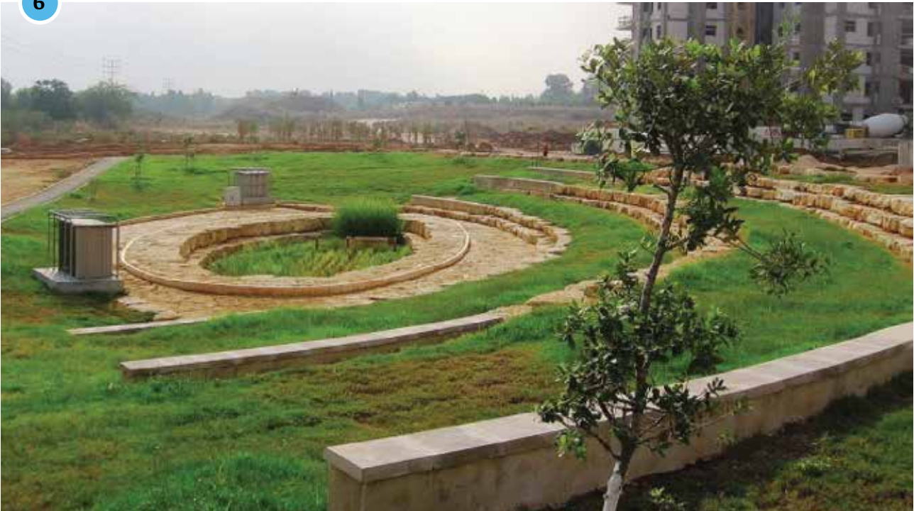
ביופילטר רב שימושי-היברידי בכפר סבא להשבת מי נגר עירוני בחורף ולהחדרתם - ולשיקום מי תהום מזוהמים בקיץ במופע נוף של אמפיתאטרון התמונה באדיבות ד"ר ירון זינגר
