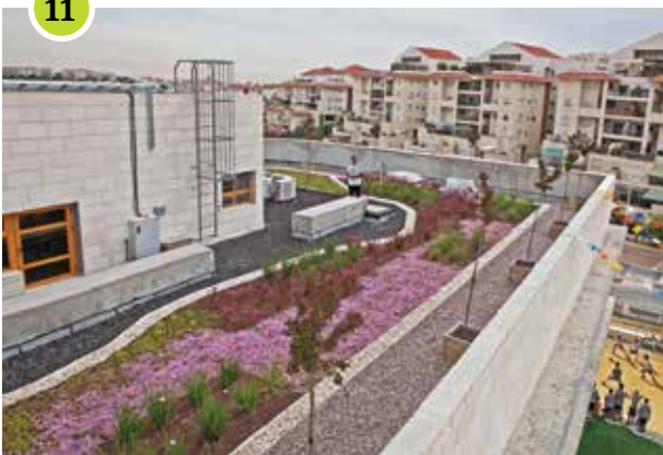
גג ירוק אינטנסיבי בקומה 3 של ביה"ס שוהם, 300 מ"ר במצע גידול פרלייט ו-400 מ"ר בחיפוי אגרגטים וחלוקים | אדריכלות נוף: טל רוסמן | תכנון וביצוע: רוני בנין, גנרון מערכת ממוחשבת רגילה ביצוע: גנרון | מימון: המועצה המקומית שוהם והחברה למשק וכלכלה | שנת ביצוע: 2010 | התמונה באדיבות רוני בנין, גנרון
